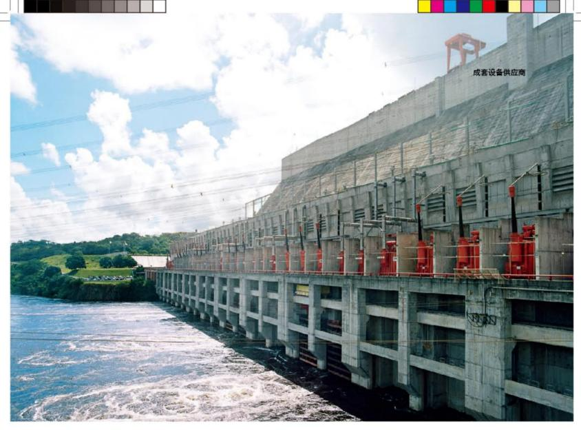
在委内瑞拉古里2号水电厂的水轮机现代化改造将把五台水轮机的 输出功率都提升5.5%。
