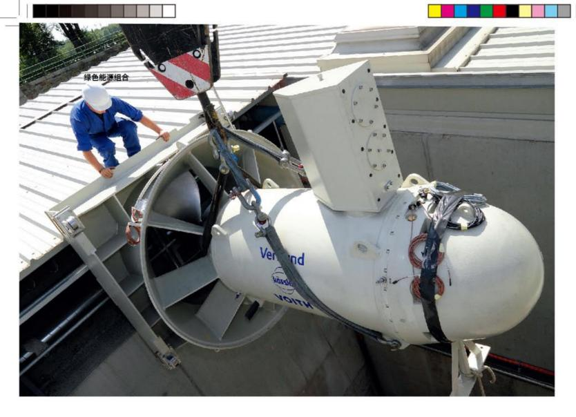
因为尺寸小,所以StreamDiver尤其适合已经有基石和建筑的场所,可以调整小型河床。它需要的维护量很少,只需要每五年进行一次技术检查。
