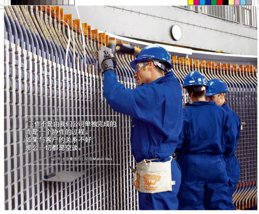
通过对发电机进行现代化改造,可以将设备的使用寿命延长几十年。
