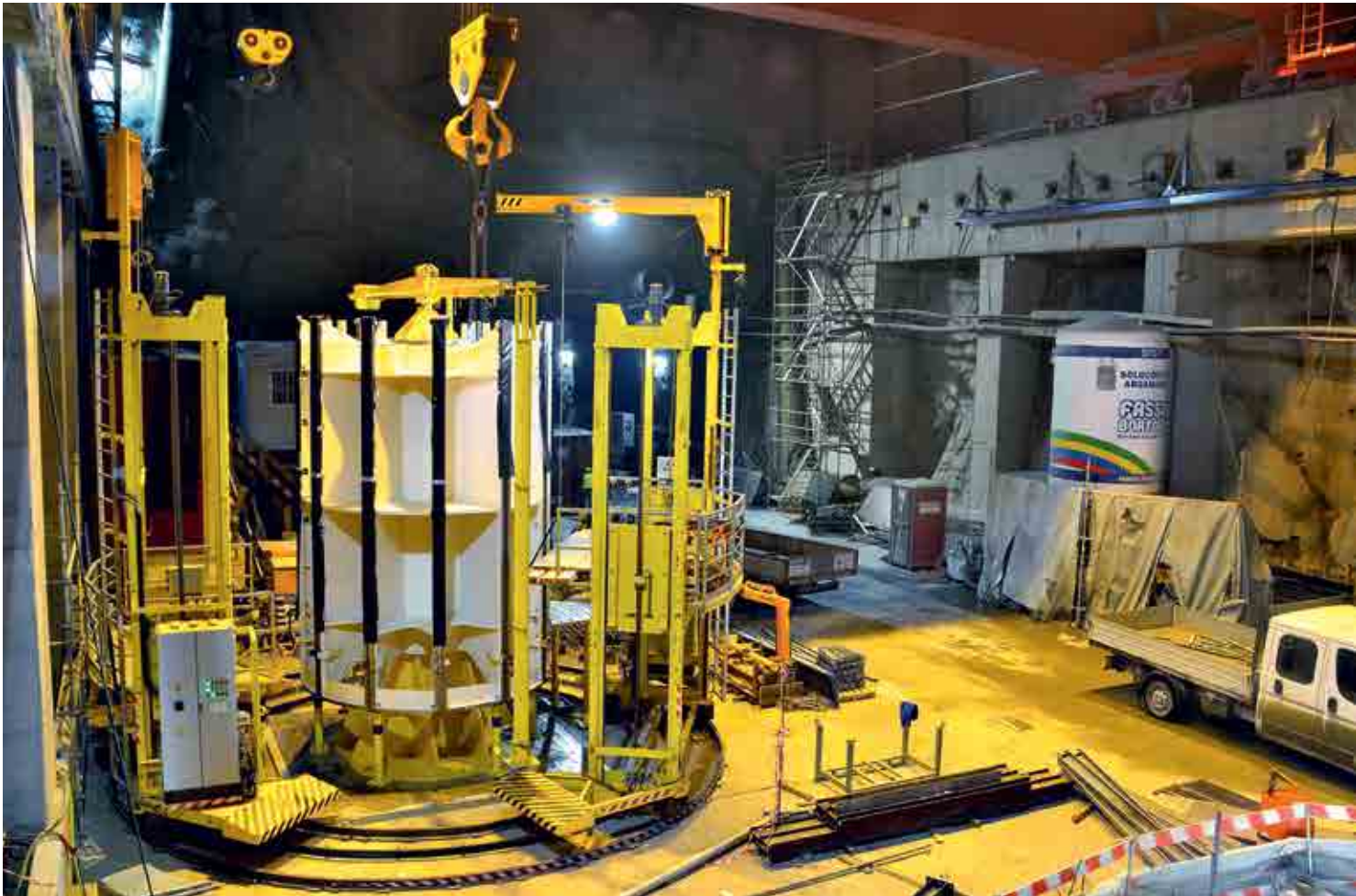
Cubo do rotor com a plataforma de empilhamento semiautomática recentemente desenvolvida no local de pré-montagem, antes do início da laminação.
