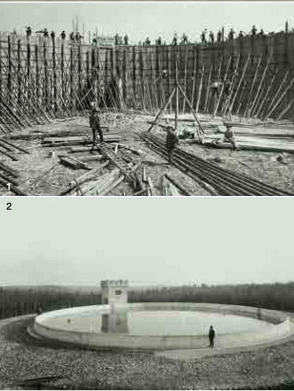
1 Construção do reservatório, com oito metros de profundidade. 2 O reservatório concluído e cheio em cima das colinas no entorno de Heidenheim.
