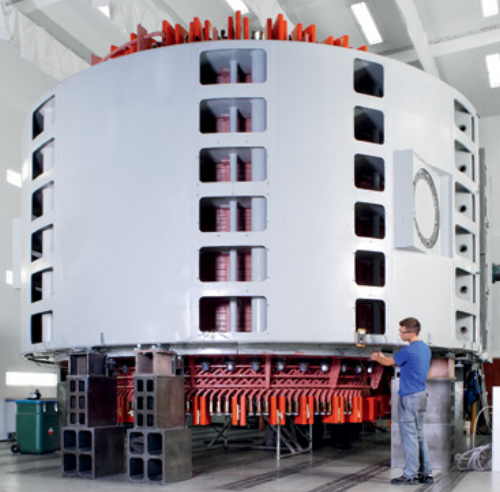
Trabalho de modernização realizado em um dos geradores de Wehr.
