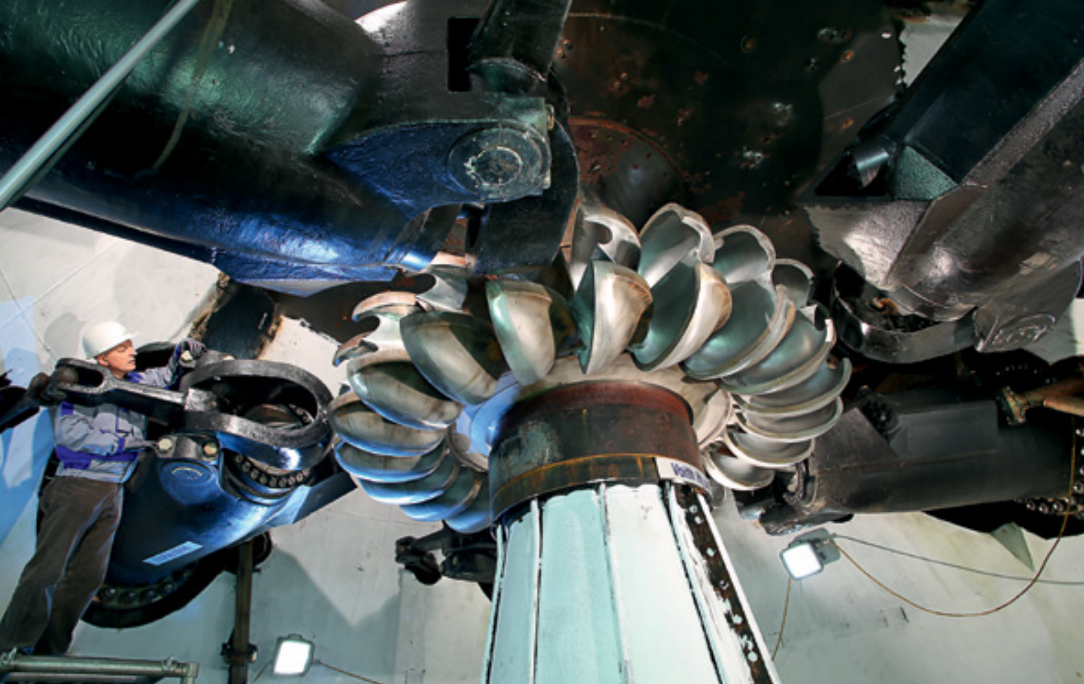
Rotor Pelton com injetor Tosi modificado, completamente montado após a revisão e pronto para o comissionamento.
