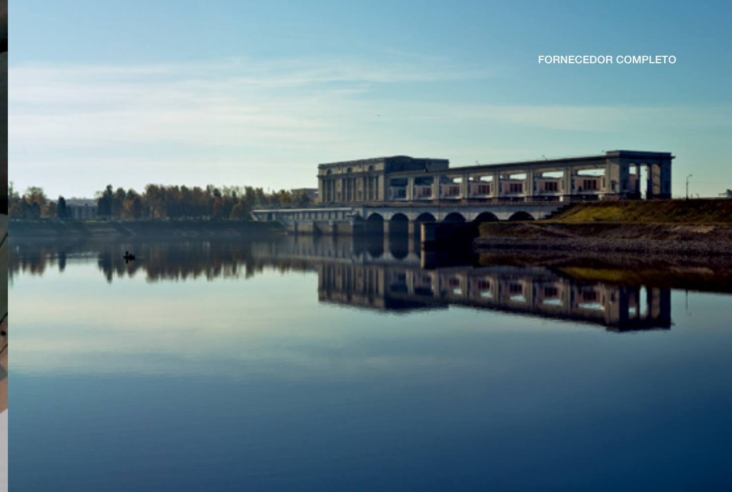
Em Uglich, na Rússia, a Voith Hydro realizou um amplo trabalho de modernização, o que aumentou a capacidade da unidade em aproximadamente 20 por cento.
