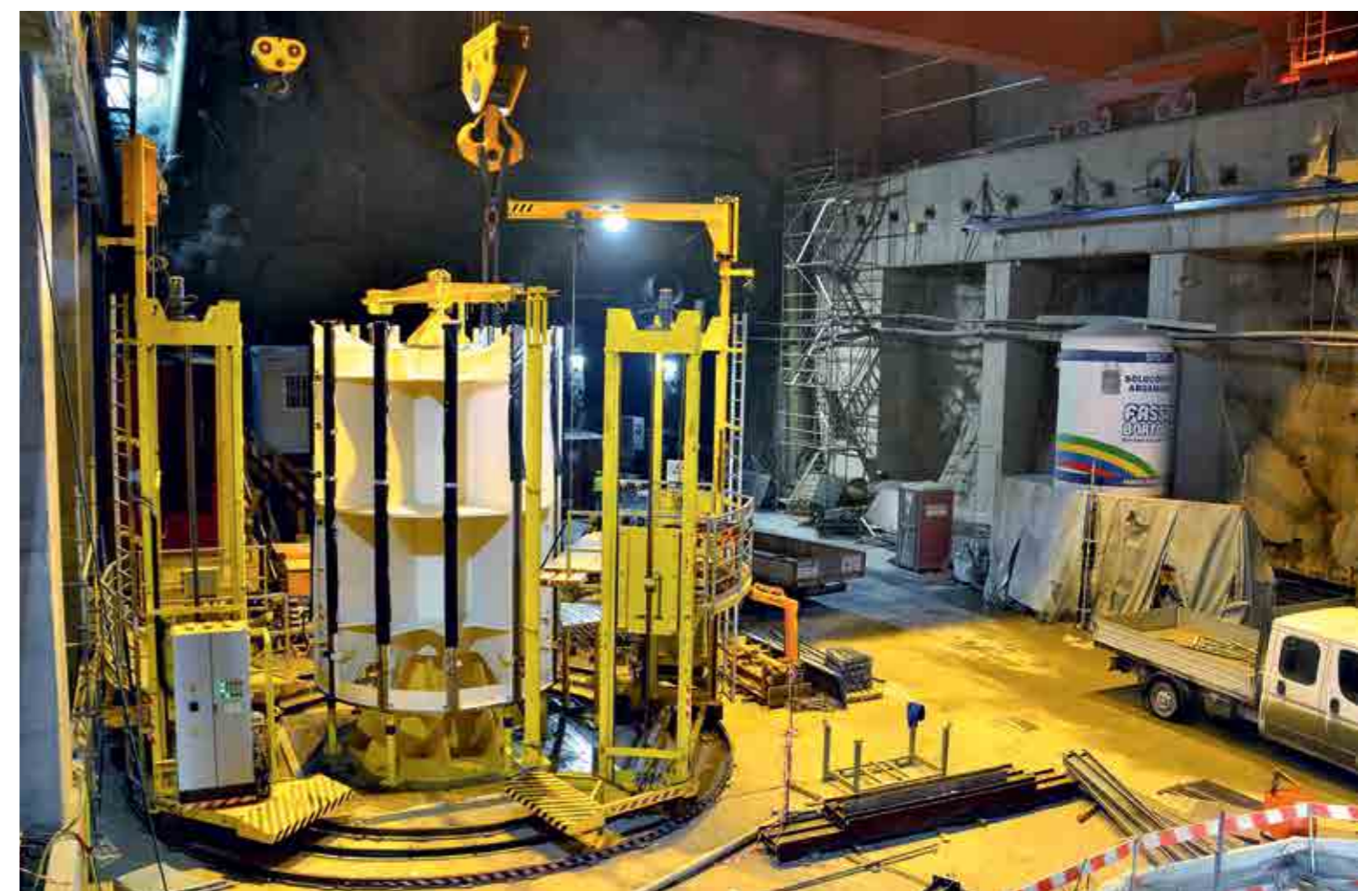
El cubo del rotor con la plataforma de apilamiento semiautomática recientemente desarrollado en el local de premontaje, antes del inicio de la laminación.
