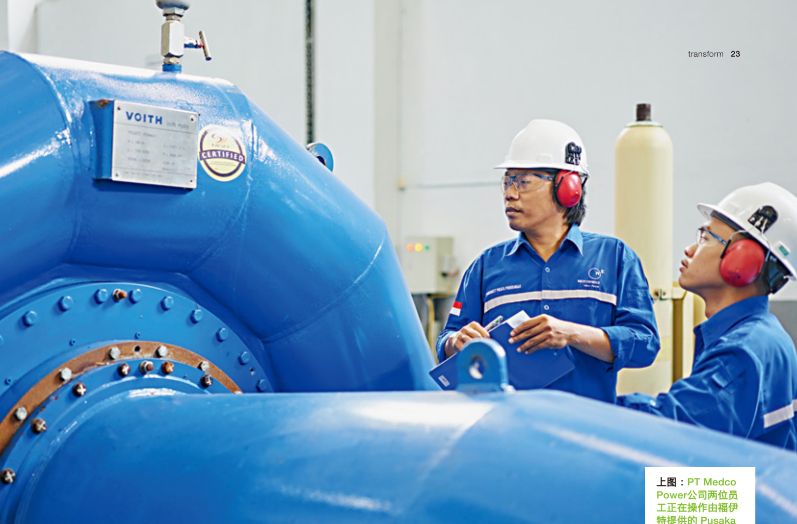
下图：Pusaka 1 收到两台新的卧式混流式水轮发电机组
