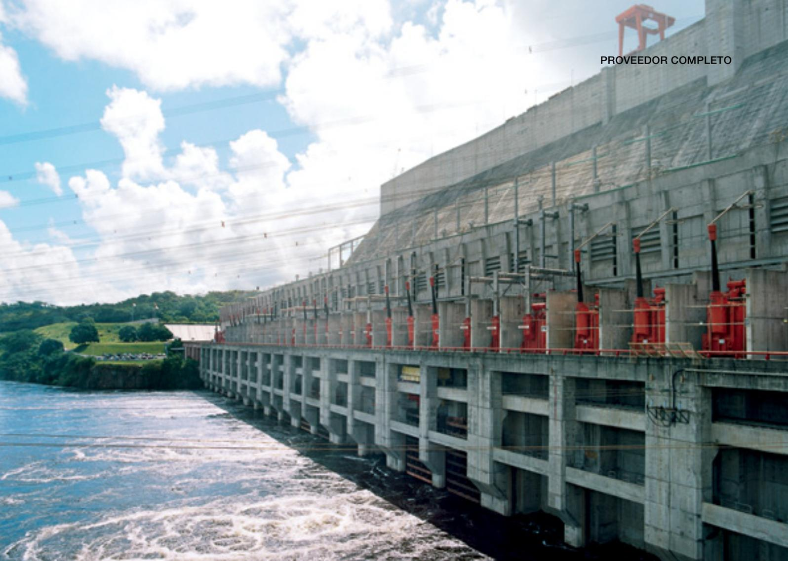
La modernización de las turbinas en la central hidroeléctrica de Guri II aumentará la potencia de cada una de las cinco turbinas en un 5,5%.
