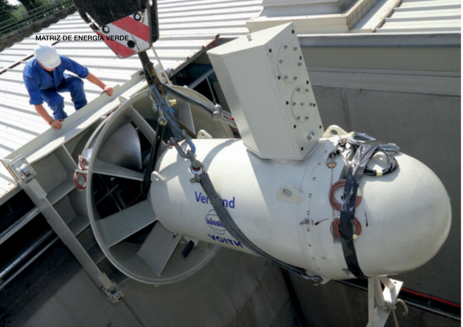
Debido a su reducida dimensión, la turbina StreamDriver es especialmente útil en áreas donde ya existen soleras y estructuras para la regulación de pequeños cauces de ríos. La turbina requiere poco mantenimiento e inspecciones técnicas solamente a cada cinco años.
