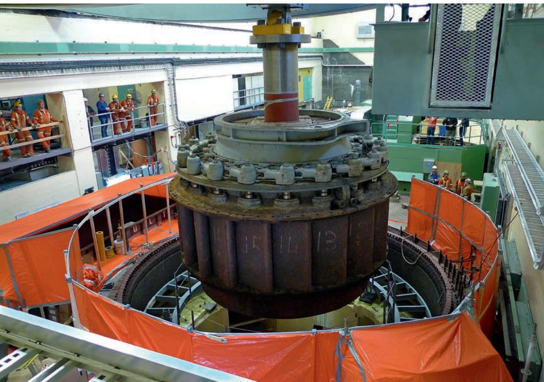
Ein Leitapparat wird aus dem Maschinenhaus in Rapides-des-Quinze in Québec, Kanada, gezogen.
